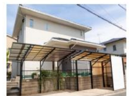
アルミの外張 涼暖くん施工後
